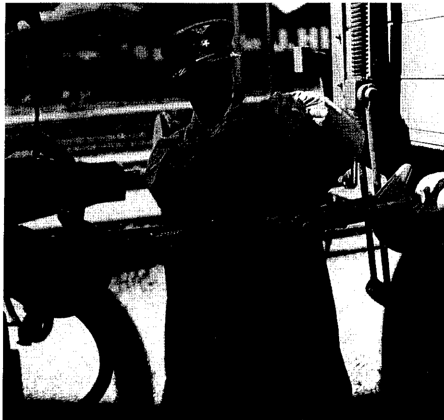
Abb 37: Ein Rangierarbeiter der SBB verbindet zwei Eisenbahnwagen mit der Haken- und-Ösen-Kupplung, um 1960.
