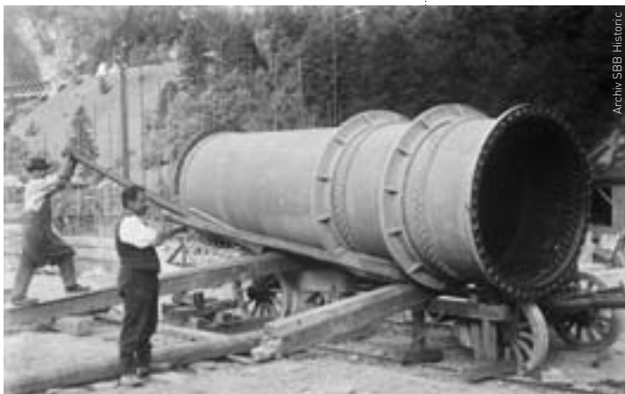
(links) Der Entscheid der SBB 1916, die Gotthardlinie zu elektrifizieren löste viele Aufträge aus. Druckröhre des Kraftwerks Amsteg um 1920. (rechts) Werkfoto der MFO mit Elektrolokomotive Ce 6/8 II «Krokodil», die einen Schnellzug die Nordrampe hinaufzieht, um 1920.
