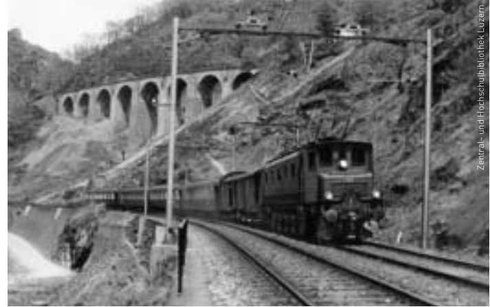
(links) Cherstelenbachbrücke 1953 mit Fischbauchverstärkung, 1953 mit zwei Krokodilen vor einem Güterzug. Neben dem Bau von Lokomotiven, Kraftwerken und Stromleitungen mussten für die Elektrifizierungen Brücken verstärkt und Tunnelsohlen tiefer gelegt werden. (rechts) Schnellzug mit Ae 4/7 der BBC mit Buchli-Einzelachsantrieb um 1930 in der Biaschina im Tessin.
