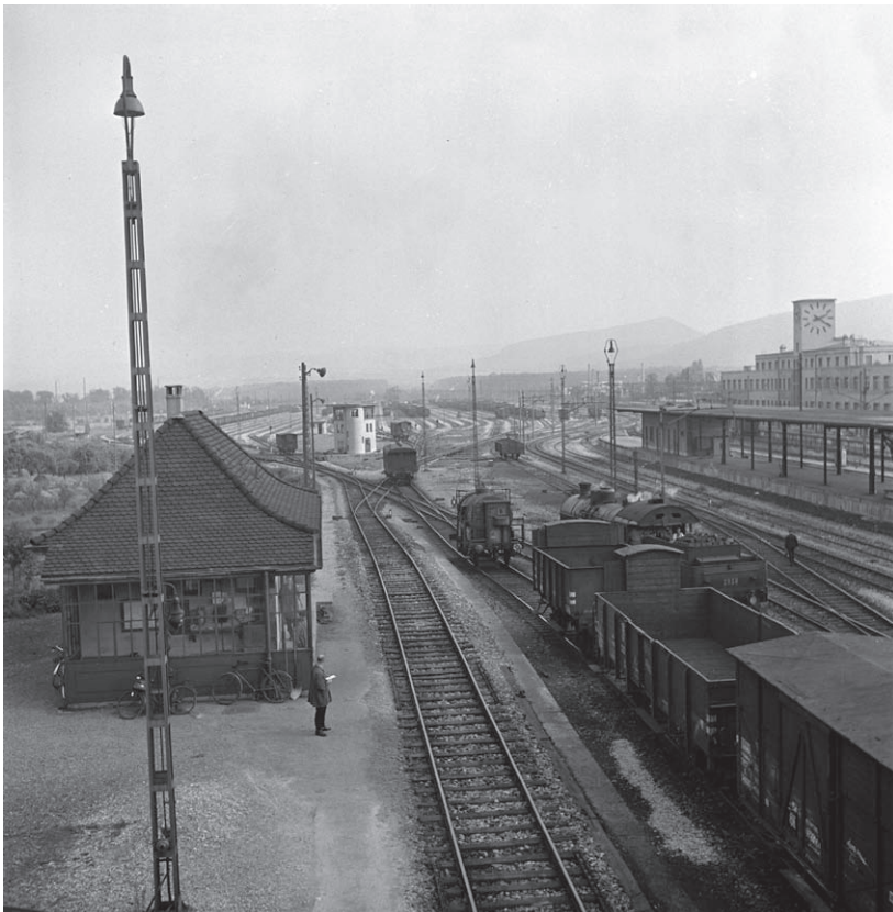
Blick vom Ablaufberg Richtung Stellwerk mit Gleisbremsen, im Hintergrund die Richtungsgruppe. Die Fotos auf S. 28 sind im hellen Stellwerkgebäude links des Bildzentrums aufgenommen worden. (Archiv SBB Historic)
