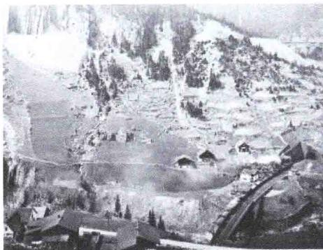
Sicht auf die obere Wattlingerbrücke nach 1893. Zur Stabilisierung des Geländes baute die Gotthardbahngesellschaft oberhalb des Bahntrasses unzählige Stützmauern. Die Steinhalde links oben besteht aus Ausbruchmaterial des Naxbergtunnels, der von der Rohrbachbrücke (rechts oben) Richtung Göschenen führt. Bild: Sammlung Verkehrshaus der Schweiz, Luzern
