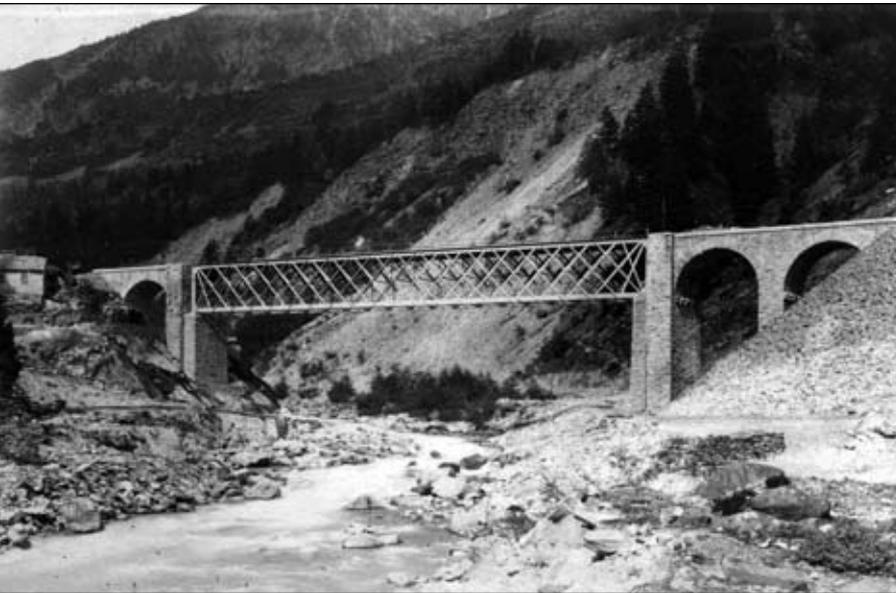
▲ Die Eisenfachwerkbrücken der Gotthardlinie wurden von der Gutehoffnungshütte (Oberhausen) gebaut und montiert, hier die Polmengobrücke bei Faido kurz nach der Eröffnung der Strecke. (Foto: Roland Arnet, 1882)
